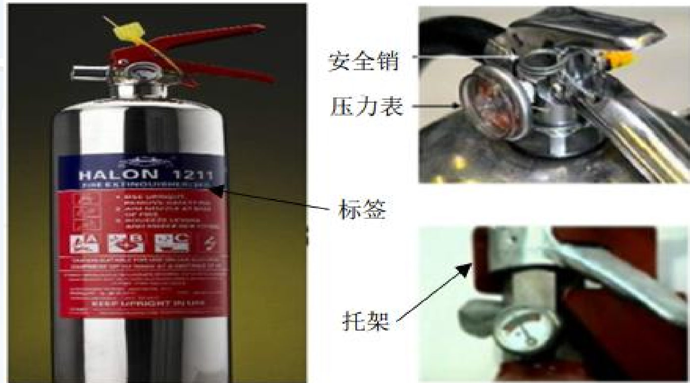
图13-30 手提灭火瓶的检查
