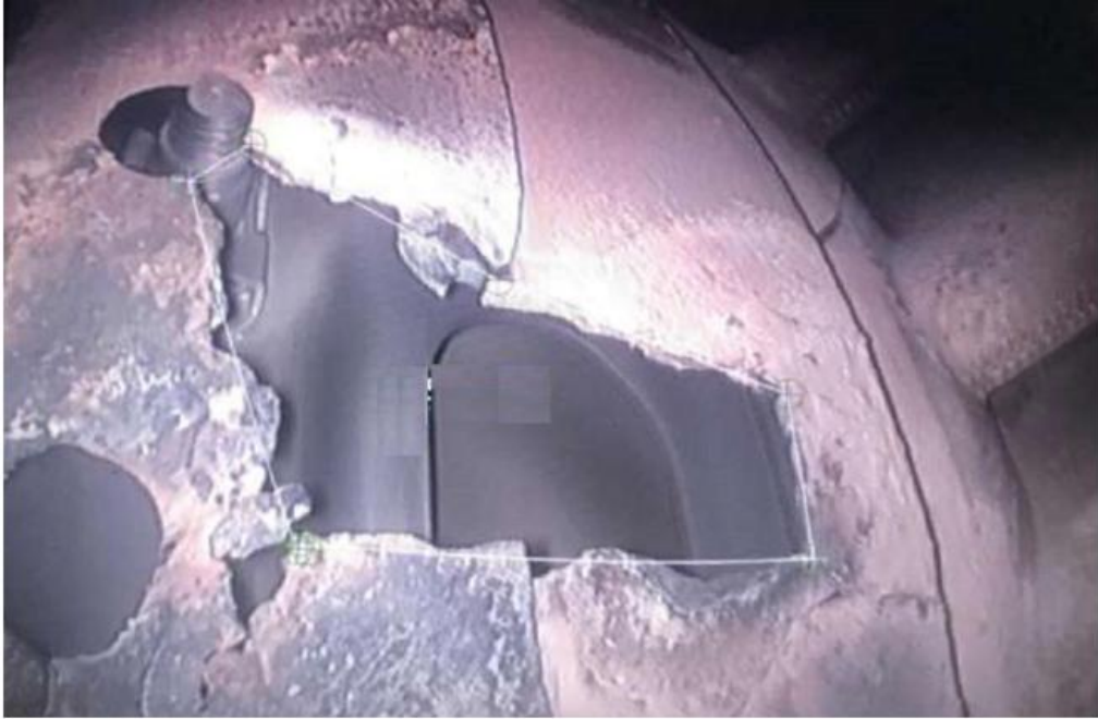
图 4-16 燃烧室的孔探检查
