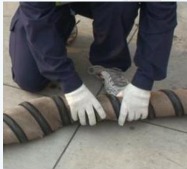
维修人员正在检查气源管路
