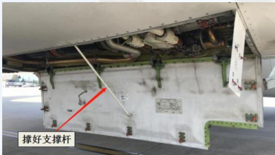
空调舱舱门打开撑起撑杆
